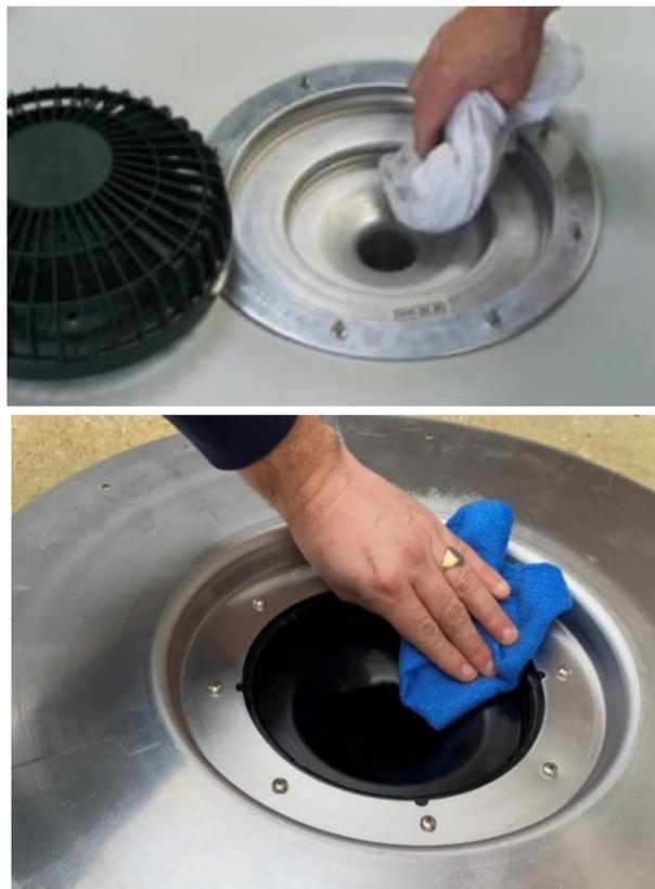
**Figure 39 – Nettoyage de l'intérieur de la platine aluminium**
