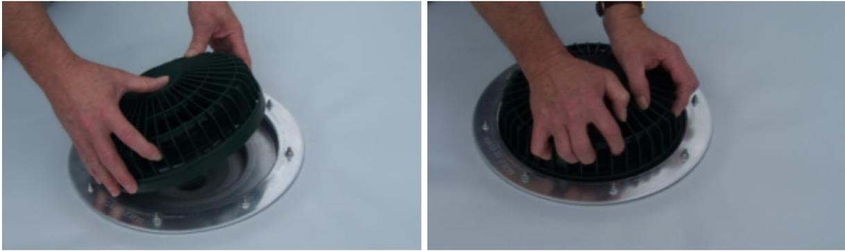
**Figures 41 – L'ensemble soucoupe – panier à feuilles est clipsé sur la platine aluminium**
