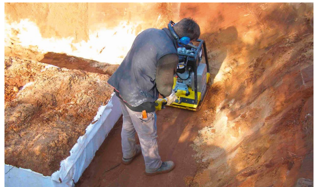
Compaction de l'espace de travail à côté du bassin.
