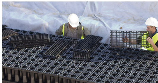
Pose des modules.
